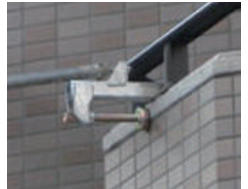
手摺付きベランダ上部への設置例
