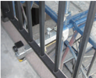
ベランダ下部への設置例(躯体側より)
