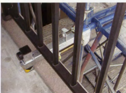
ベランダ下部への設置例(躯体側より) (先端ひっかけ金具を逆にして溝に固定します。)
