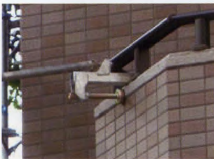
手摺付きベランダ上部への設置例
