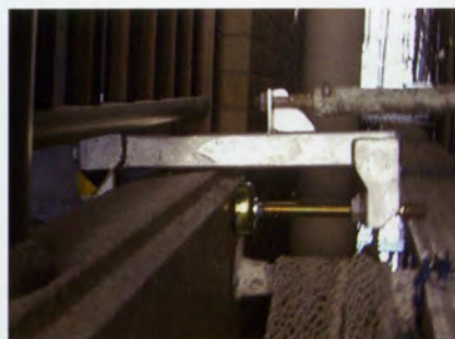
ベランダ下部への設置例(足場側より) (ゴムパッキング等は取り換え可能です。)
