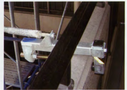
通路側手摺の設置例
