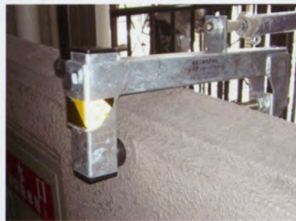
ベランダ上部への設置例(躯体側より)
